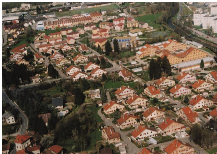
L'ensemble immobilier de la Viscamine – le grand bâtiment à droite – est aujourd'hui devenu le lycée « Pierre du Terrail »
